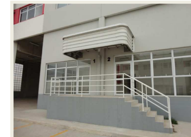
Acesso à parte administrativa do bloco A
