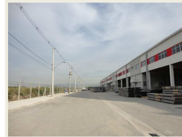
Área de circulação interna
