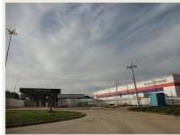
Acesso ao empreendimento e portaria
