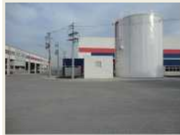
Área de circulação interna
