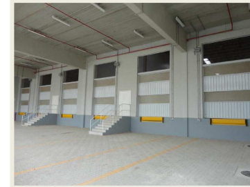
Docas e acesso do bloco A
